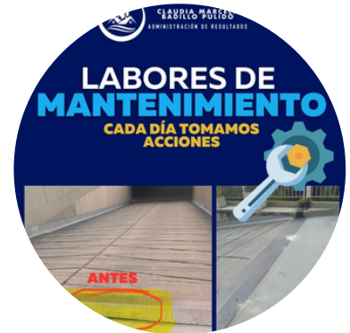
Labores de mantenimiento en la rampa vehicular
