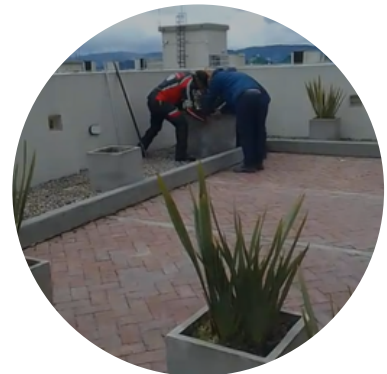
Retiro de materas de los borde de las cubiertas
