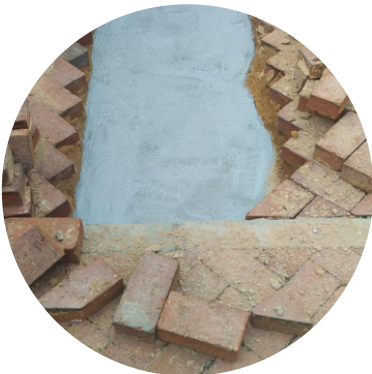
Impermeabilización de humedades
