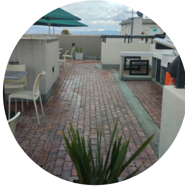
limpieza de cubiertas ( terrazas )
