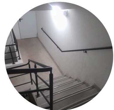
LIMPIEZA DE ESCALERAS DE EMERGENCIAS
