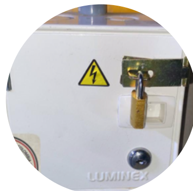
INSTALACIÓN DE CANDADOS EN LAS CAJAS ELECTRICAS DE LAS ZONAS COMUNES
