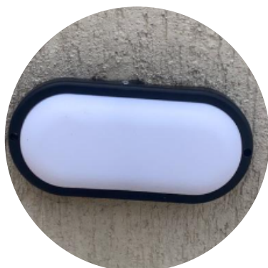
CAMBIO DE ILUMINARIAS DAÑADAS EN TORRE 2
