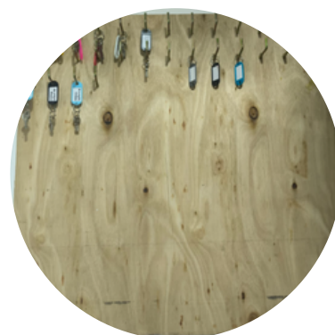
INSTALACIÓN DE TABLERO PARA LLAVEROS DE AREAS COMUNES
