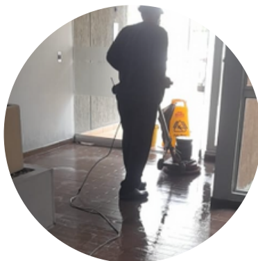
DECAPADO DE TODOS LOS PISOS DE TORRE 4
