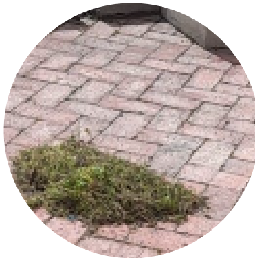
DESHIERBA EN LAS CUBIERTAS
