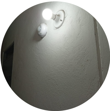
CAMBIO DE BOMBILLOS DAÑADOS EN SOTANOS
