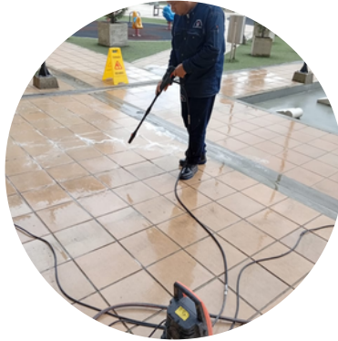
PRELAVADO CON HIDROLAVADORA A LAS ZONAS PEATONALES DE LA PLAZOLETA
